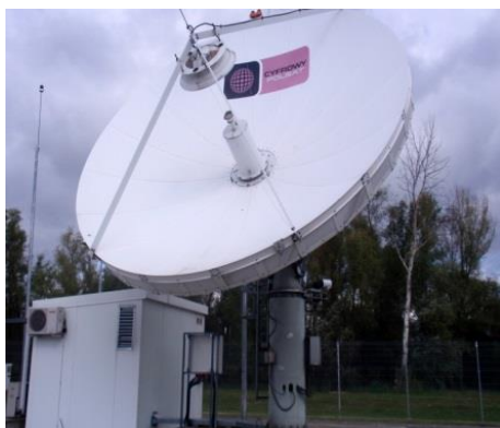
Fig. 2. One of the antennae of the platform Cyfrowy Polsat S.A. (Warsaw)
