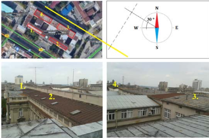
Slika 3. Delovi krova zgrade Tehničkih fakulteta raspoloživi za izgradnju PV panela
