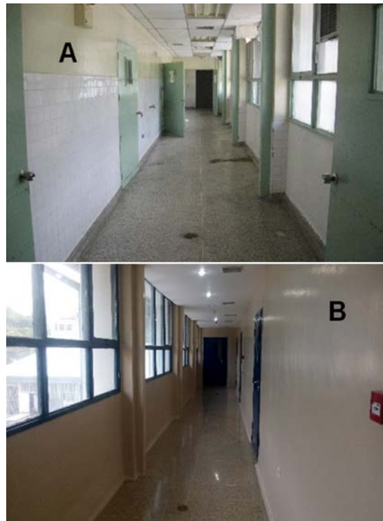
Figura 2. Área de pasillos. A: antes de la remodelación: paredes con baldosas y techo tipo cielo raso. B: después de la remodelación, remoción de baldosa, sustitución de techo estructuras de dry wall Fuente: elaboración propia
