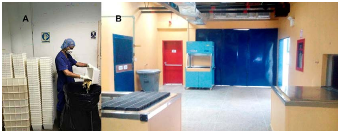
Figura 7. Limpieza de jaulas. A: Antes de la remodelación y B: después con incorporación de Cabina Flujo Laminar CS5 para limpieza de jaulas
