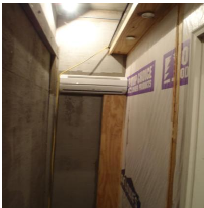
Figura 9. Sección externa de la Casa Laboratorio.
