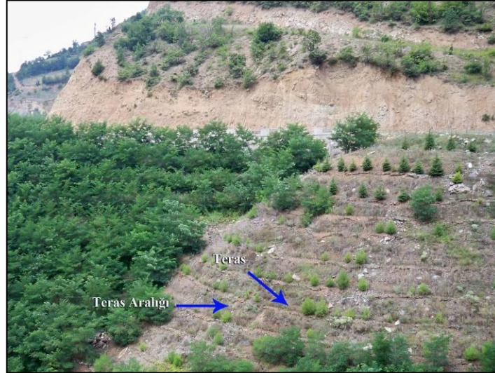
Şekil 3: Erozyon kontrolü ve ağaçlandırma çalışmalarının yapıldığı alandaki teras ve teras aralığının görüntüsü.
