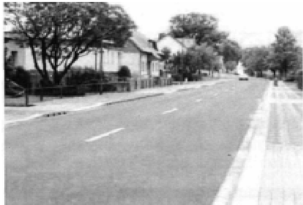
Рис. 7. Загальний вигляд лінійного водовідводу
