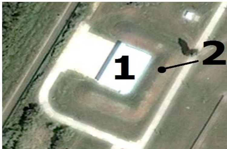
Рис.2. Общий вид зоны размещения хранилища твердого ракетного топлива: 1 – хранилище твердого ракетного топлива; 2 – защитный вал
