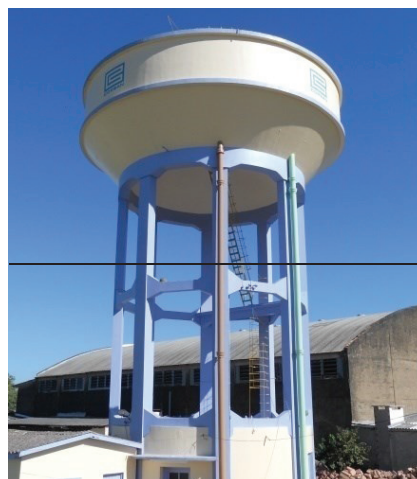
Figura 1- Reservatório elevado no pátio da ETA, em Candelária/RS.
