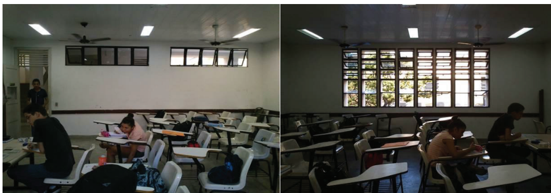
Figura 7 – Fotos da sala no Bloco Central (P5) mostrando as aberturas para ventilação.
