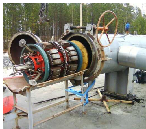
Фиг. 3. Приемна камера за запускане на вътретръбни инспекционни прибори
