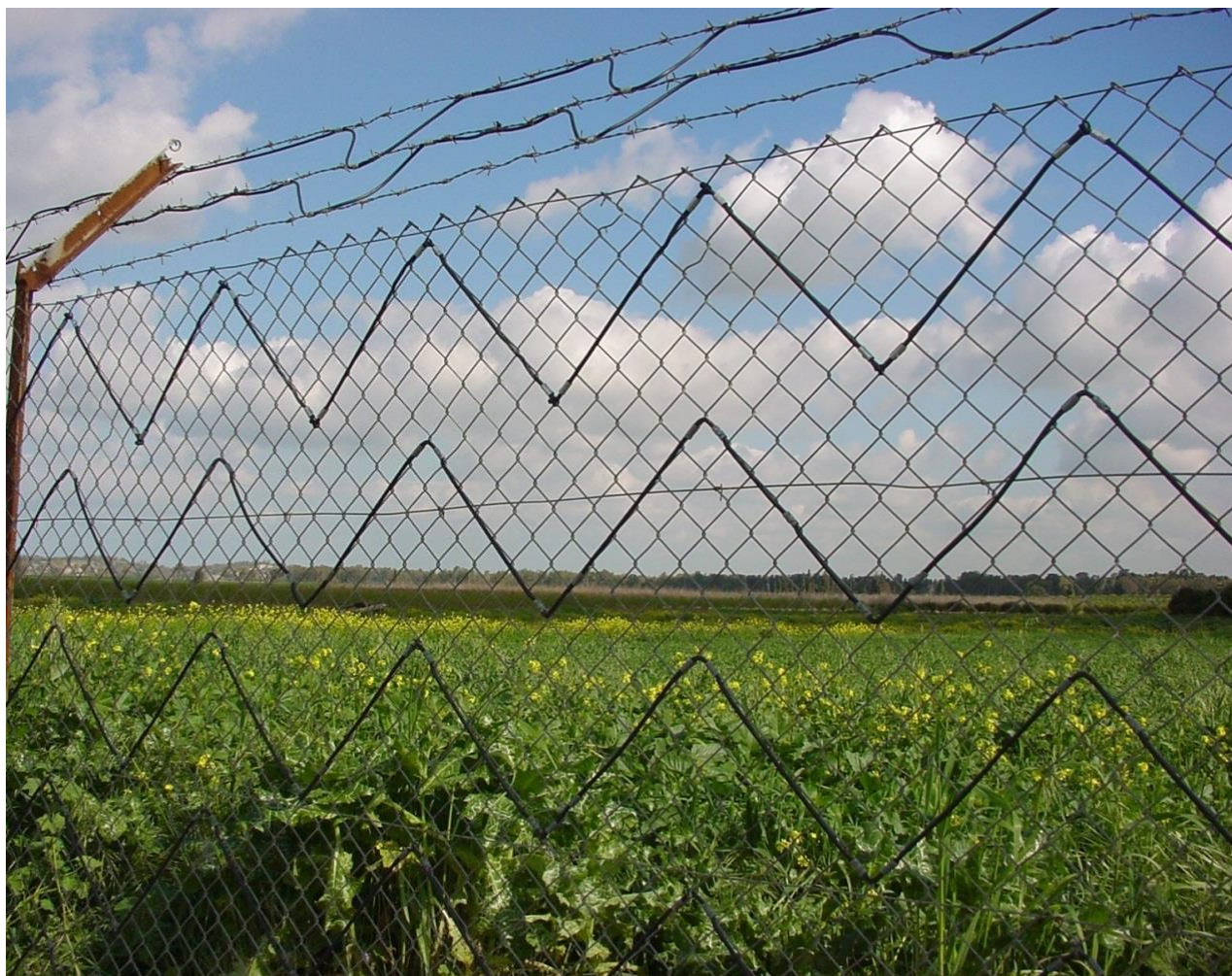
Рис. 2. Вибрационные датчики, закрепленные на ограждениях
