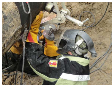
Фиг. 4. Ремонтване /подмяна/ на участък от газопровод след диагностика Fig. 4. Repair / replacement / section of a pipeline after diagnosis
