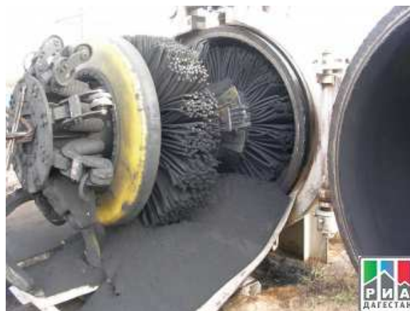
Фиг. 1. Почистване и диагностика на участък от магистрален газопровод Fig. 1. Cleaning and diagnostics section of the highway gas pipeline
