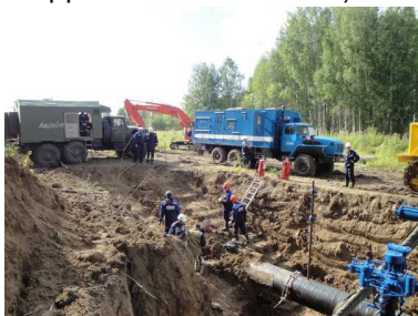
Фиг. 4. Ремонтване /подмяна/ на участък от газопровод след диагностика Fig. 4. Repair / replacement / section of a pipeline after diagnosis
