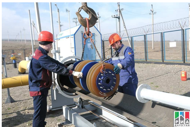
Фиг. 1. Почистване и диагностика на участък от магистрален газопровод Fig. 1. Cleaning and diagnostics section of the highway gas pipeline
