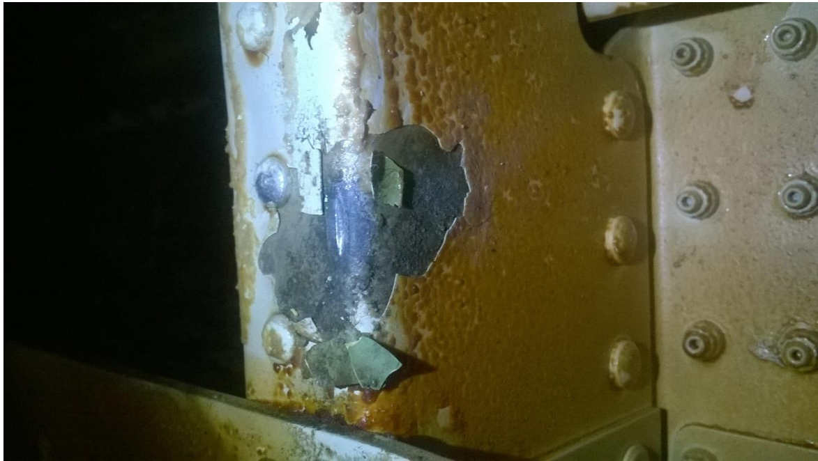
Rys. 11. Ubytek zabezpieczenia antykorozyjnego (w tym farby) oraz korozja wręgi w kabynie pasażerskiej powstałe na skutek zawilgocenia izolacji cieplnej w tym miejscu
