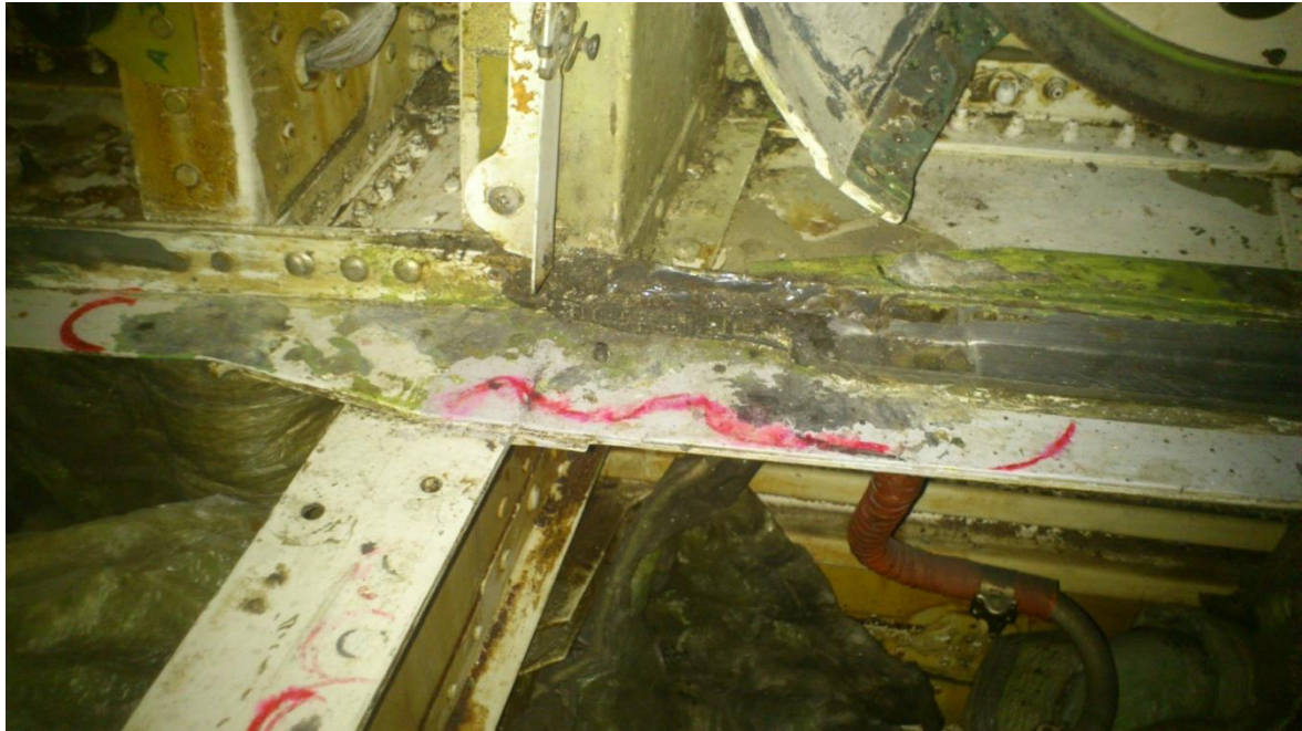
Rys. 9. Korozja listwy przyprogowej przednich drzwi serwisowych
