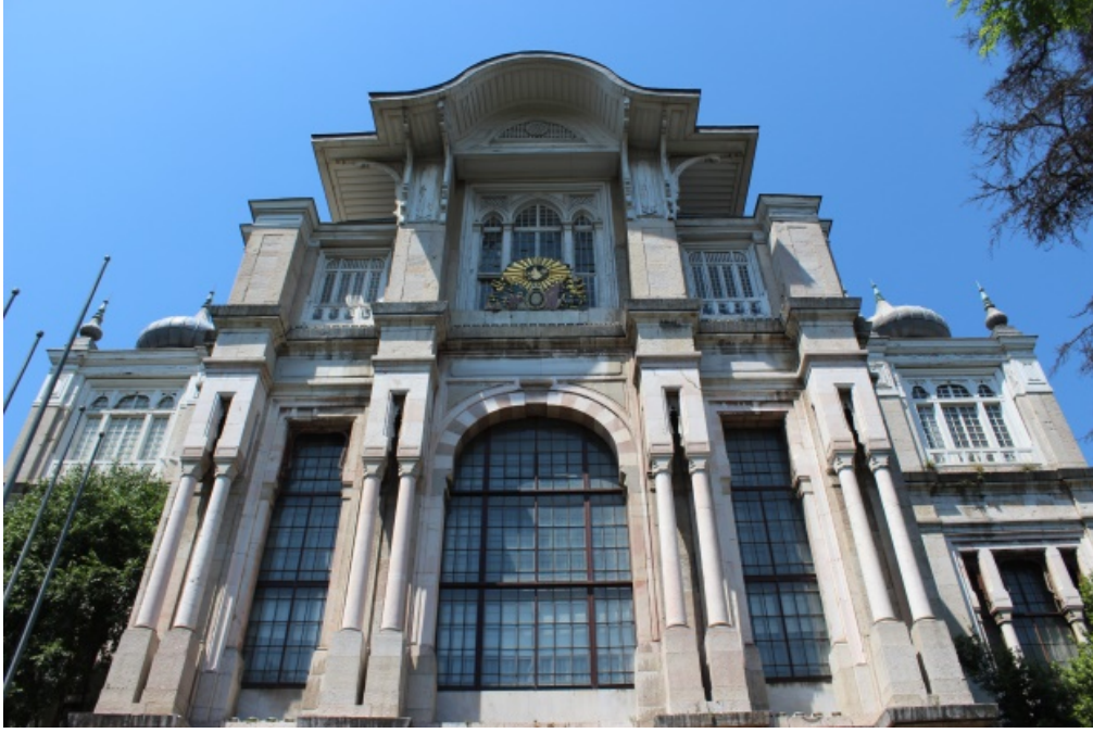
Şekil 4: Binanın kara cephesi, giriş detayı (Haziran 2015)
