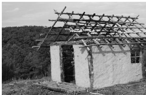
Рис. 2. Дерев'яний каркас покрівлі
