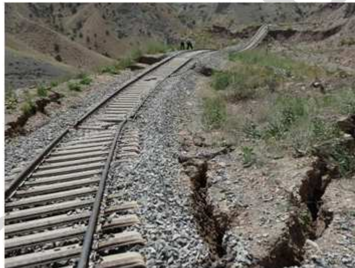
شکل ۹. رانش زمین و انحراف خط از محور در مرداد ۱۳۸۸ در موقعیت ۲
