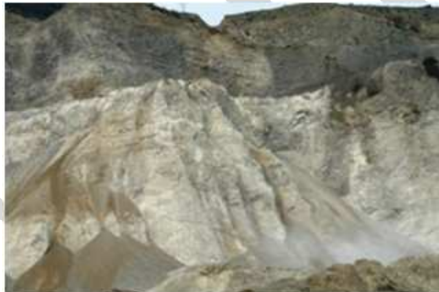
شکل ۱۱. تصویری از برداشت‌های نامناسب که موجب ناپایداری شیب دامنه شده است (نگاه به سمت غرب).
