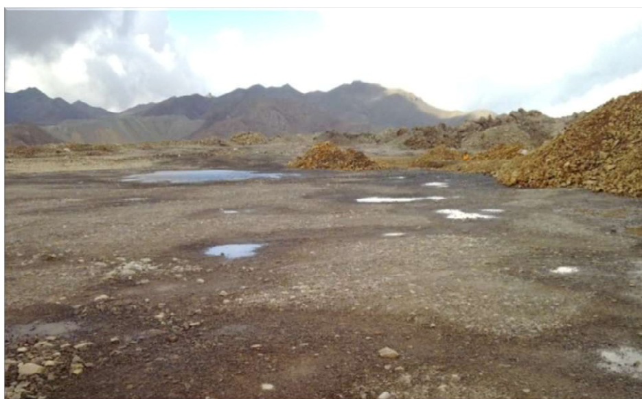
شکل 9. باقی ماندن آب باران پس از گذشت 24 ساعت از پایان بارندگی روی کومه 31 معدن سرچشمه، آذر 1390
