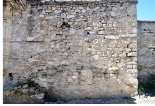
Fotođraf: 39 Hamamın kuzey duvarı, ana giriş kapısının batısı. (Kapı bitiřindeki tamirat izleri, yeni tuđla ile ahřap hatıl kullanımı burada açıkça görölmektedir) (2015).
