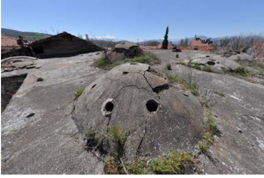
Fotoğraf: 23 Hamamın çatısı, kubbelerdeki fil gözü delikleri (2015).
