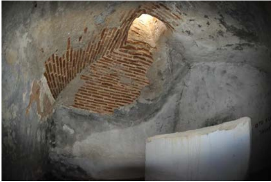
Fotoğraf: 16 Sıcaklık bölümü, tıraşlık mekânının üst örtüsü (2015).
