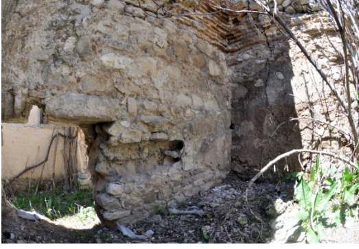
Fotoğraf: 31 Üzeri kubbe olduğu anlaşılan mekânın güney duvarında kalan iki pöhrenk sırası ve duvardaki açıklık (2015).
