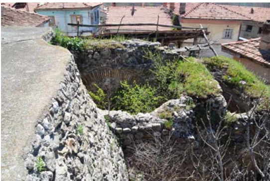
Fotoğraf: 28 Hamama bitişik, güney yöndeki yıkılmış bölümlerin bir kısmı (Ara duvar dışa doğru esnemıştır) (2015).
