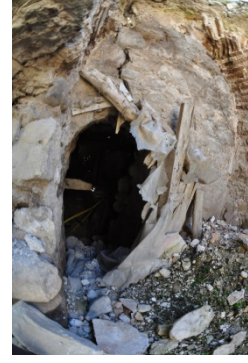
Fotoğraf: 33 Ahırdan tonozlu mekâna açılan kapı (ahırdan görünüm) (2015).
