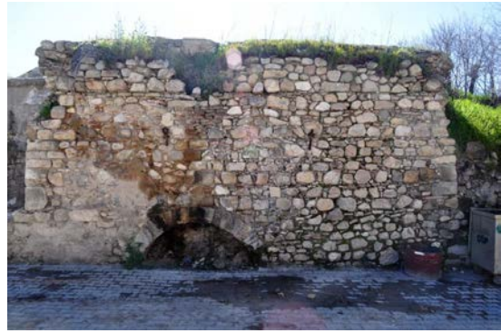
Fotoğraf: 27 Hamamın batı cephesindeki külhanın girişi (2015).
