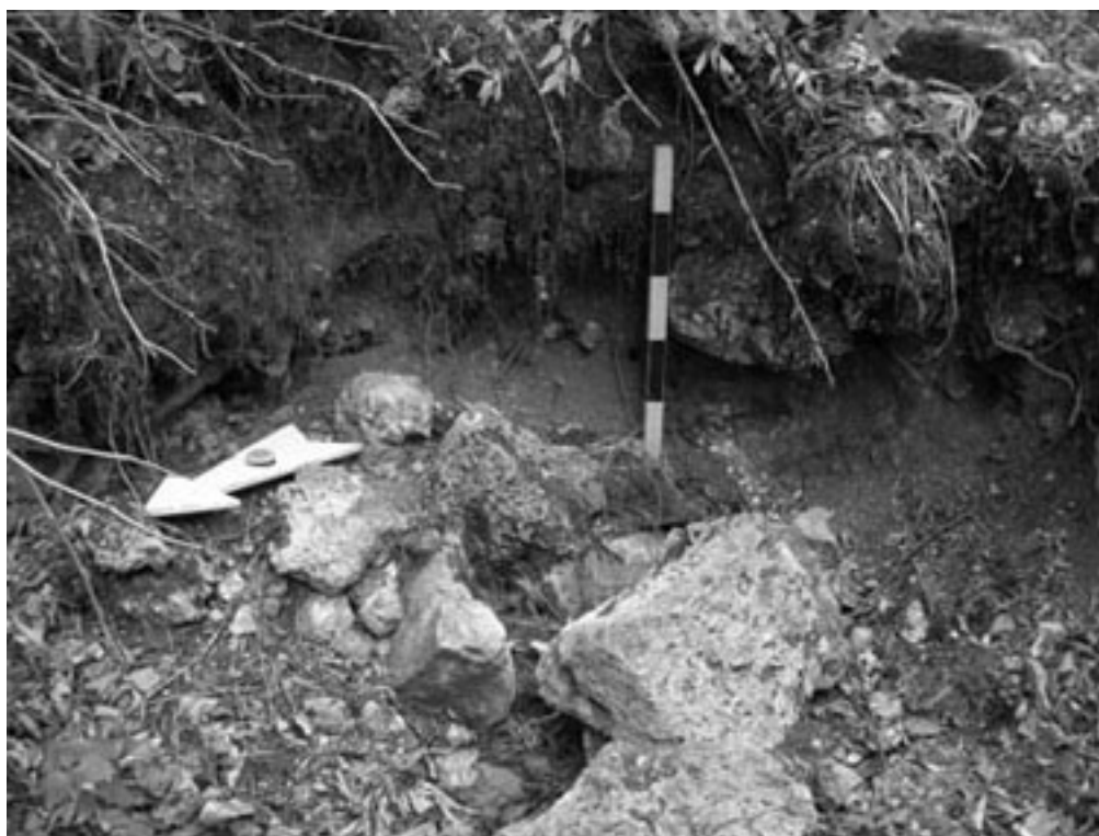
Рис. 10. Разрушенные стены храма.
