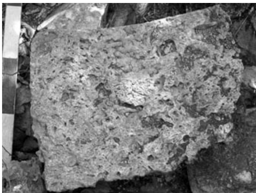
Рис. 8. Фрагменты туфовых арочных перекрытий.
