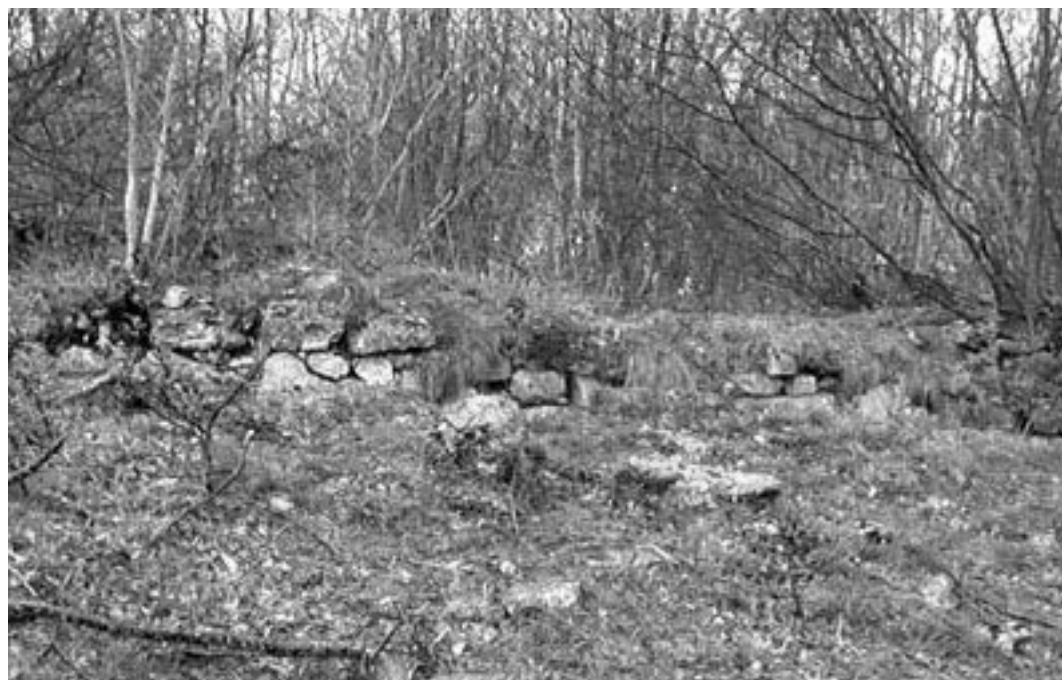
Рис. 9. Стены храма. Современное состояние (лето 2007 г.).
