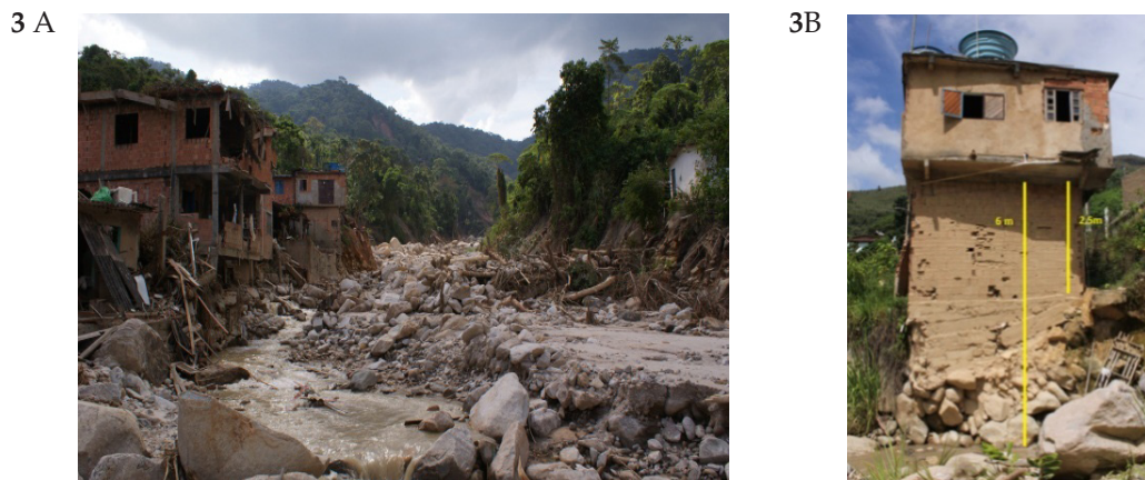
Figura 3: a) Erosão do leito maior em Campo Grande, destacando-se a grande quantidade de blocos. b) Casa danificada. A escavação do leito do rio tem em torno de 3,5 m (vide na figura b as escalas de 6 m e 2,5 m)
