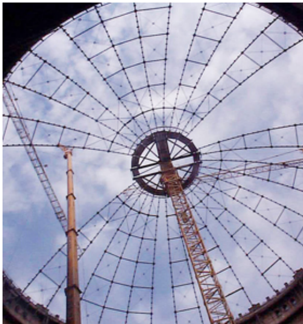
Рис. 5. Демонтаж конструкцій покриття за допомогою тимчасової опори
