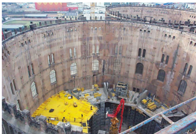
а б Рис. 7. Бетонування конструкцій стін та перекриттів
