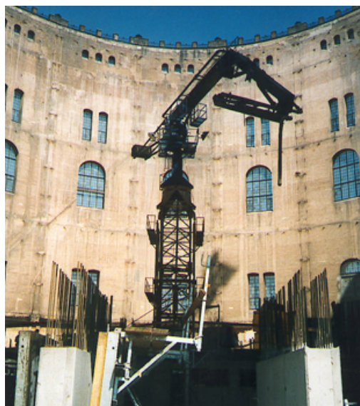
а б Рис. 7. Бетонування конструкцій стін та перекриттів
