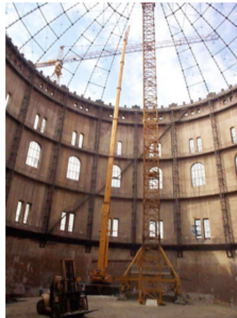
Рис. 5. Демонтаж конструкцій покриття за допомогою тимчасової опори
