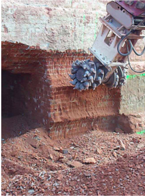
Рис. 6. Розбирання цегляних стін при влаштуванні дверних та віконних прорізів
