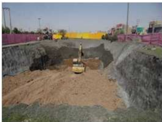
شکل ۱۷. خاک‌برداری و باربرداری از روی تونل
