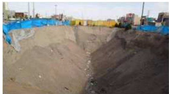
شکل ۳۰. خاک‌ریزی روی تونل بعد از اجرای بتن
