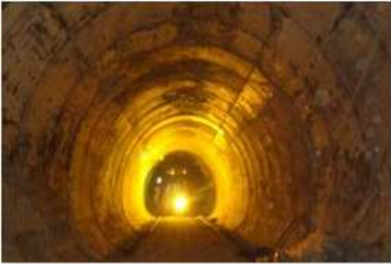
شکل ۳۸. نمایی از تونل بعد از بتن‌ریزی لاینینگ
