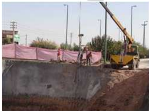
شکل ۲۶. انتقال لتیس به داخل شفت برای نصب
