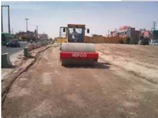
شکل ۴۰. آماده‌سازی محل ریزش برای اجرای آسفالت خیابان
