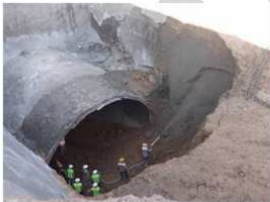
شکل ۲۵. شاتکریت دیواره برای جلوگیری از ریزش
