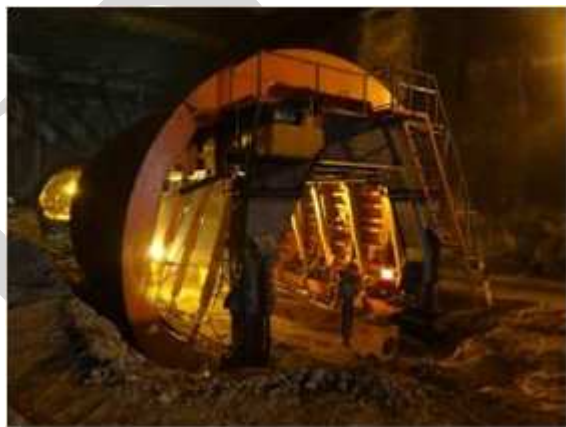
شکل ۳۶. قالب لاینینگ تونل
