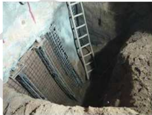
شکل ۲۰. اجرای پایه لتیس برای کامل کردن مقطع تونل
