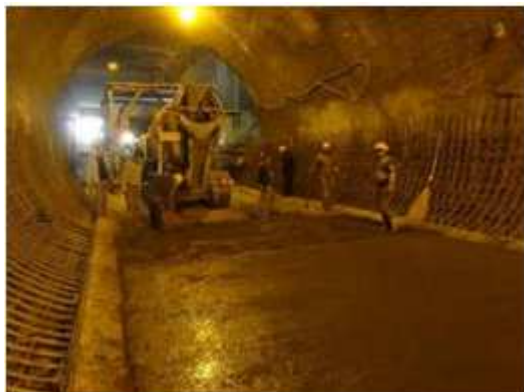
شکل ۳۳. بتن‌ریزی روی رادیه کف برای زیر ریل قالب لاینینگ
