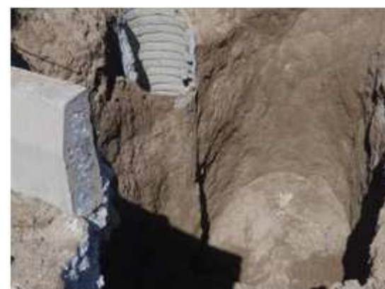
شکل ۱۳. منطقه برش تونل در محل نصب جت فن
