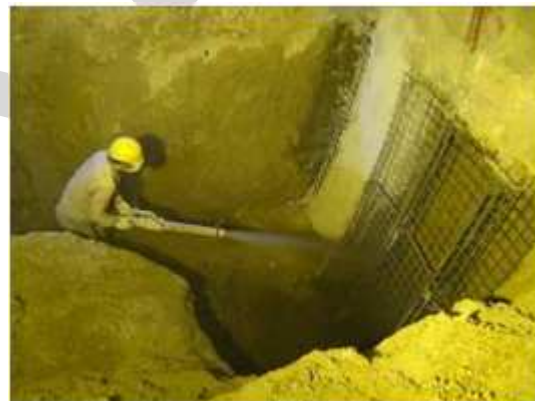
شکل ۲۱. تحکیم پایه لتیس توسط اجرای شاتکریت
