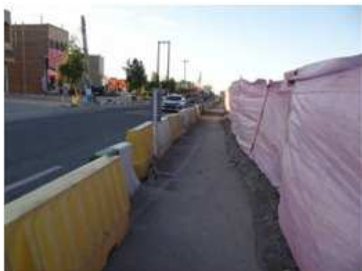
شکل ۱۵. محصور کردن محدوده ریزش
