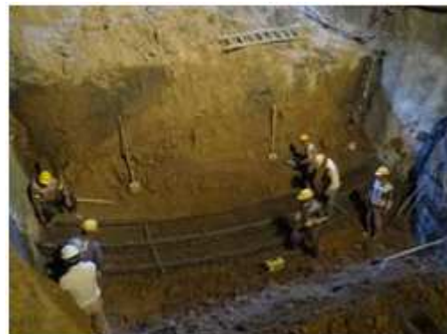
شکل ۲۲. نصب و اجرای کفبند
