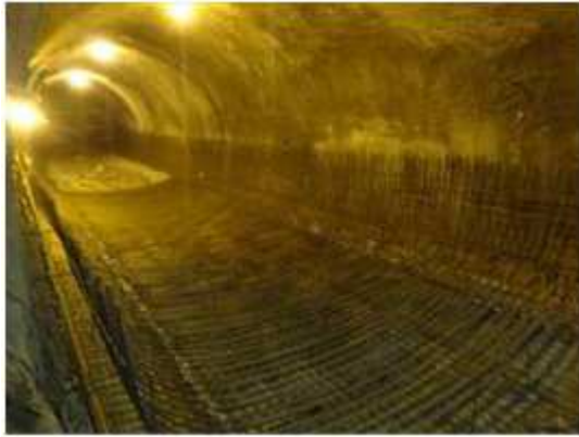
شکل ۳۱. آرماتوربندی رادیه کف تونل
