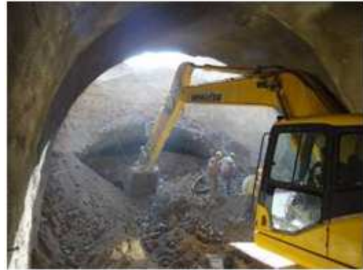
شکل ۱۹. تخریب تونل ریزش کرده به میزان ۳ متر طول
