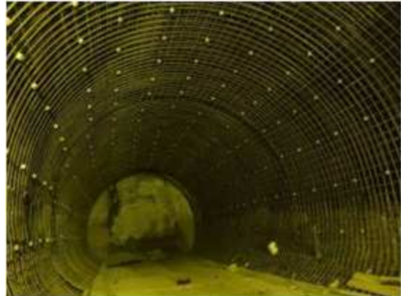
شکل ۳۵. تکمیل آرماتوربندی لاینینگ
