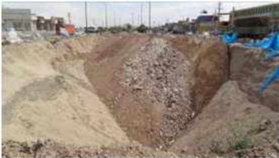
شکل ۳۹. خاک‌ریزی محل ریزش بعد از اجرای لاینینگ
