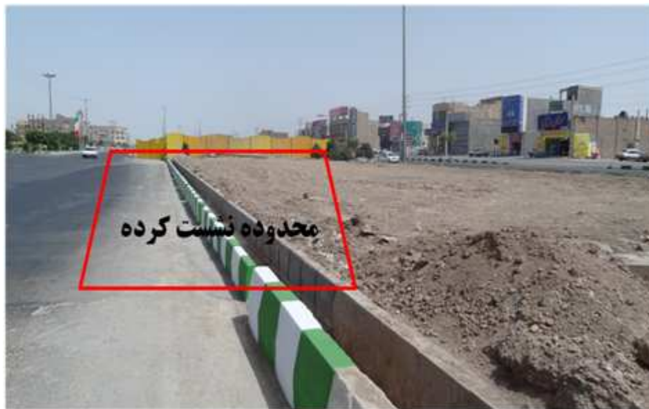
شکل ۴۲. اجرای جدول کنار خیابان و بازگشایی مسیر
