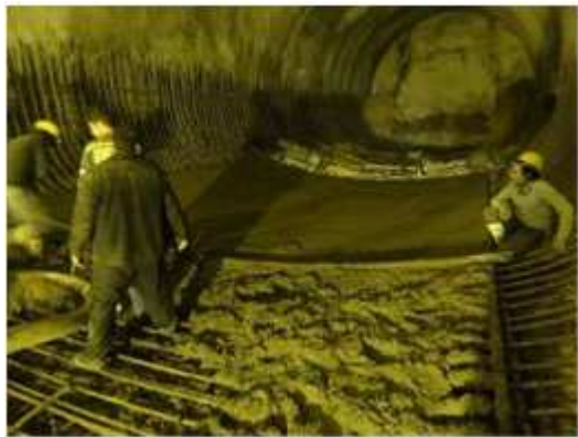
شکل ۳۲. بتن‌ریزی رادیه کف تونل
