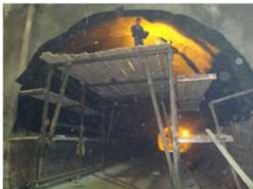
شکل ۳۴. نصب عایق ژئوممبران قبل از آرماتوربندی سقف
