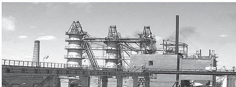
**Рис.8. Известкообжигательные печи Силикатного завода, построенные в 1965 г. (фото авторов)**
