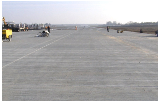
Рис. 10. Підготовка ділянки до здачі в експлуатацію
