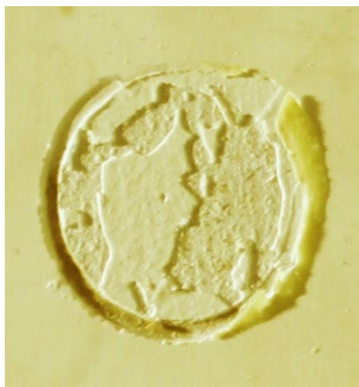
Фото 14. Отрыв VIVALDI STUCKY от FARINA DI QUARZO. Толщина оторванного слоя 220 мкм, адгезия 0,3 МПа
