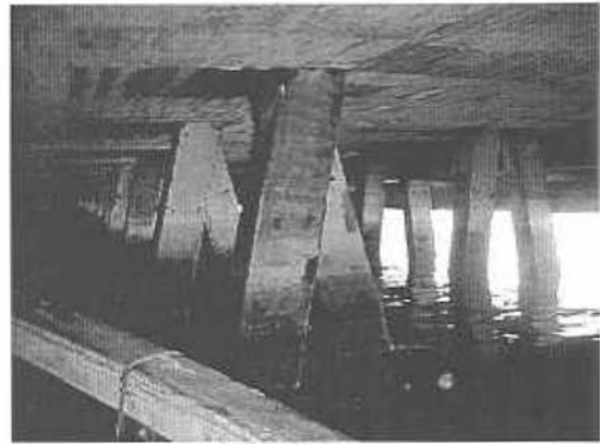
Figura 2. Disposición de pilotes
