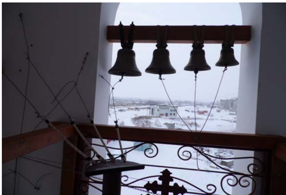
Рисунок 2. Классическая система управления колокольным звоном с тройкой зазвонных колоколов и пультом в форме «веера»
