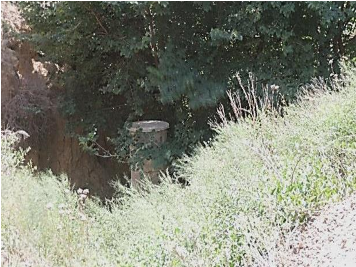
Рисунок 2. Общий вид наблюдательной скважины
