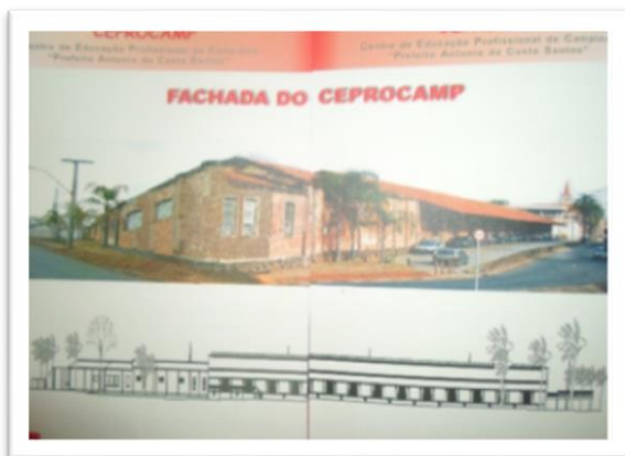
ANTES DA REVITALIZAÇÃO
