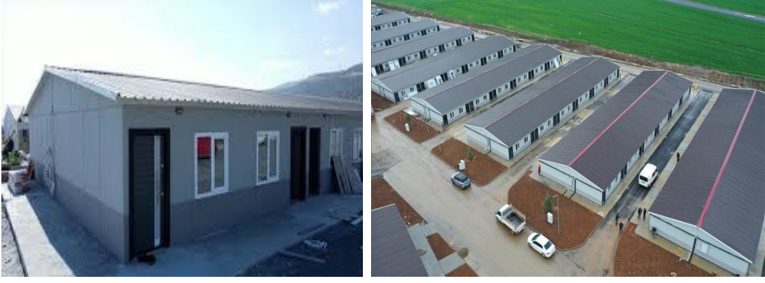
Şekil 11: Prefabrik yapı bitmiş hali (T.C. Çevre, Şehircilik ve İklim Değişikliği Bakanlığı, 2023)
