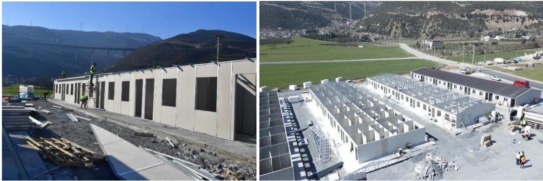
Şekil 10: Prefabrik yapı kurulumu (Anadolu Ajansı, 2023)
