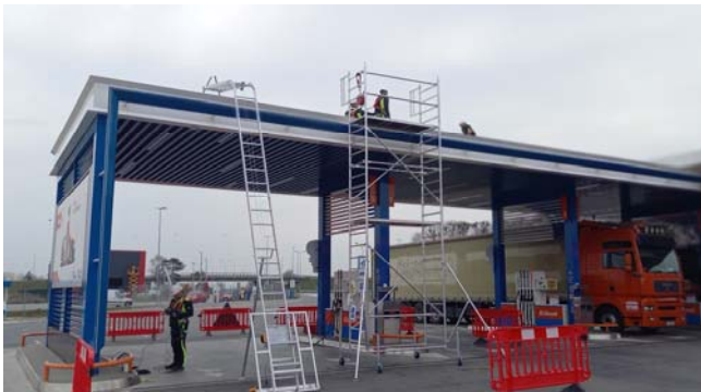
Slika 11. Izvođenje radova na SSG
