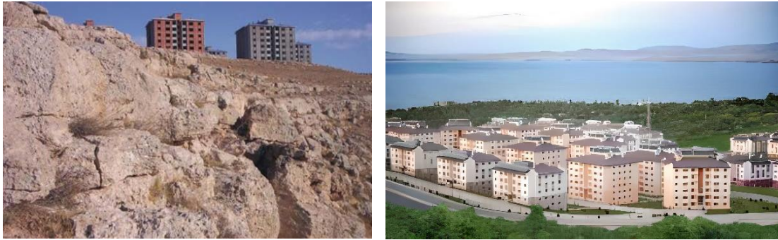
Şekil 8: Toplu alanda yer seçilen Van deprem konutları
