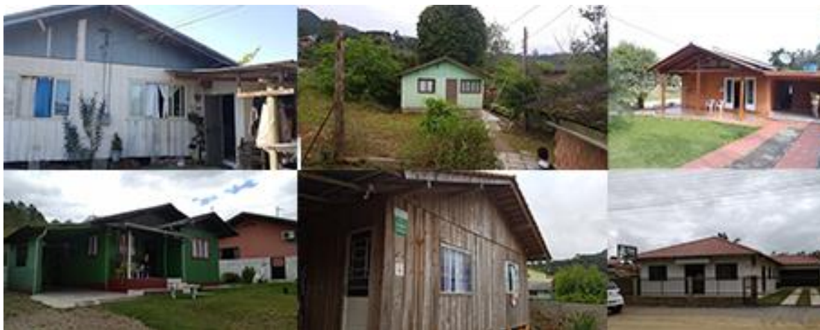
Figura 5: Residências e seus materiais empregados.
