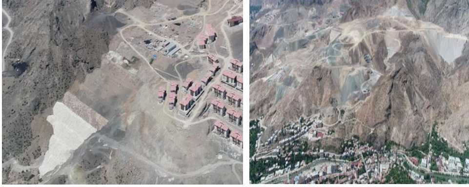
Şekil14: Yeni yerleşim alanında yapılan istinat duvarlarından ve yapılan kazı dolgu çalışmalarından örnekler (Foto: Artvin DSİ 26. Bölge Müdürlüğü)
