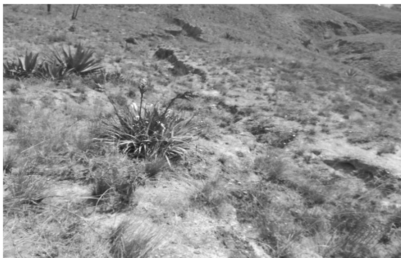
Рисунок 2. Трещина разрыва грунта в месте формирования оползня.
