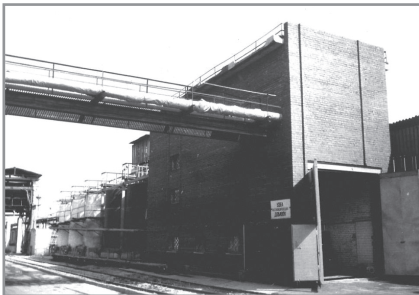
Рис. 6. Наружные трехслойные стеновые панели с гибкими связями, производимые с НаносуперЛТМ на восьми конвейерных линиях КрЗЖБК с 1986 года, проверенные на долговечность в естественных условиях эксплуатации Москвы
