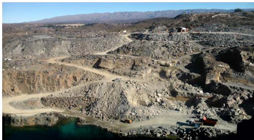
Figura 2. Foto panorámica de la cantera La Represa donde se observan accesos a diferentes frentes de explotación
