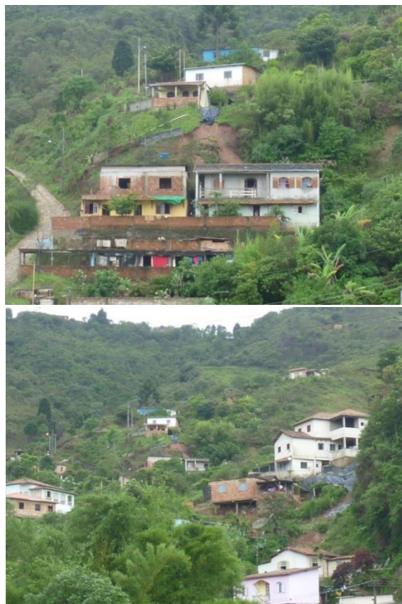
Fotos 1 e 2: Ocorrências de deslizamento de terra no Morro dos Piolhos.
