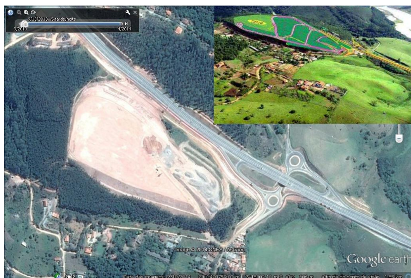
Figura 6: Polo Industrial de Paraibuna – Acima à direita figura ilustrativa do projeto, a figura maior mostra a área já com terraplanagem. Fonte: Prefeitura Municipal de Paraibuna (2013) e Google Earth (2014). Adaptado pelo autor.
