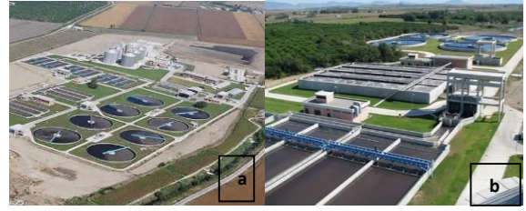
Şekil 1: Biyolojik atık su arıtma tesisi genel görünümü. (a): Batı (Seyhan) atıksu arıtma tesisi, (b): Doğu (Yüreğir) Atıksu arıtma tesisi).
