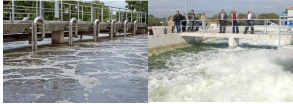
Şekil 2: Çökeltim ve havalandırma havuzları.
