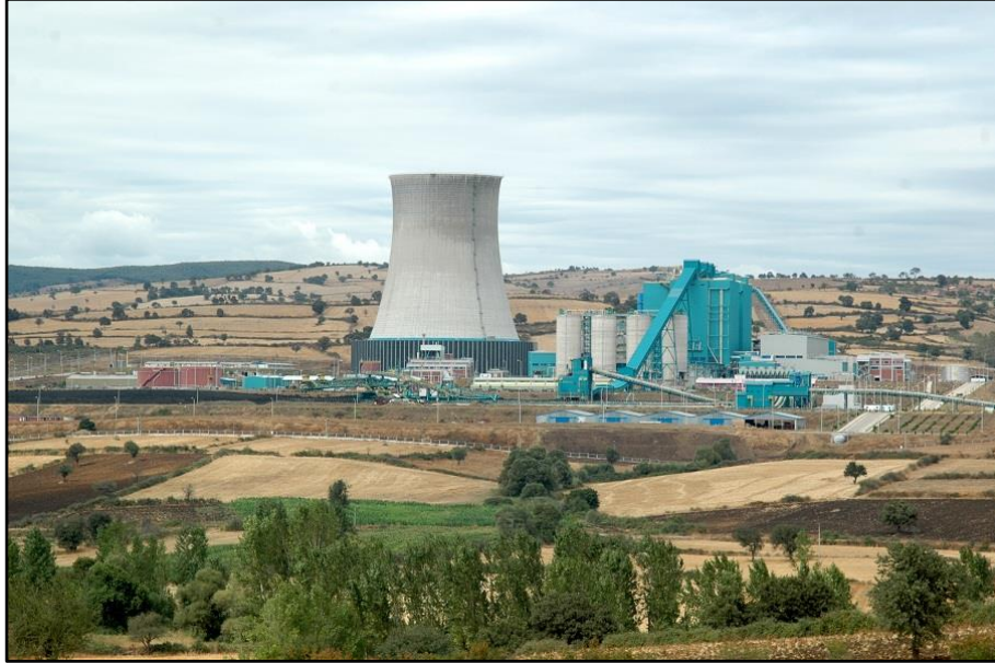
Şekil 3. Çan Onsekiz Mart Termik Santrali (2 x 160 MW)
