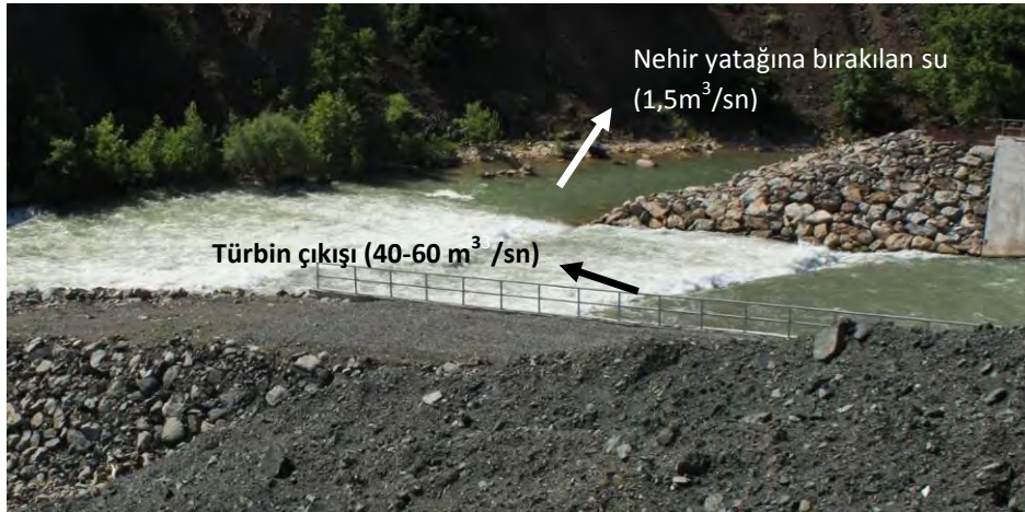
Fotoğraf 4. Çamlıca 3 HES Su ÇıkışNoktası ile Irmak Yatağı Birleşme Noktası
