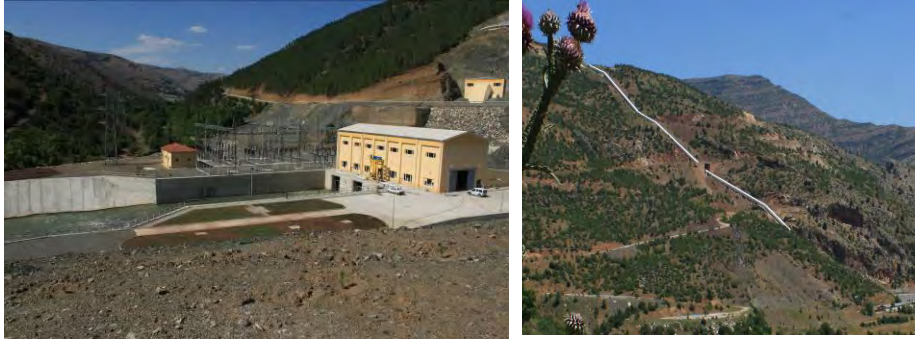
Fotoğraf 3. Çamlıca 3 ve Çamlıca 1 HES Türbin Binaları ve Cebri Boru Sistemi
