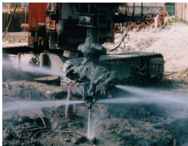
Рис. 1. Рабочий инструмент для метода струйной цементации
