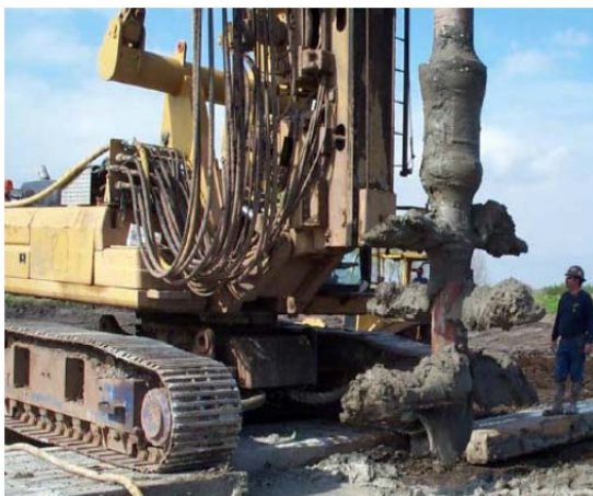
Рис. 2. Рабочий инструмент для буросмесительной технологии перемешивания грунта
