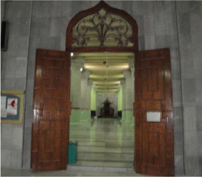
Foto pintu utama (Th.2010).
