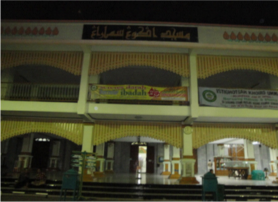
Foto: Bangunan masjid dari posisi depan (Th. 2010).
