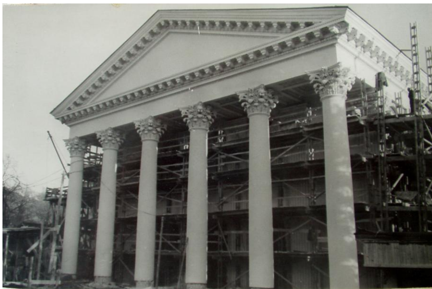
Строительство кинотеатра «Сочи» (позднее переименован в «Стерео» 1952 г.
