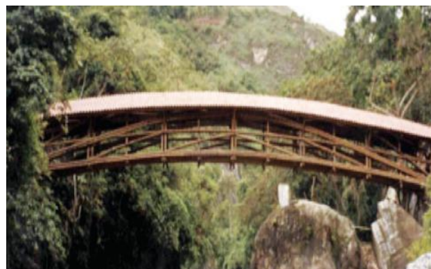
Figura 3. Puente de guadua en Colombia de Jorge Stamm.
