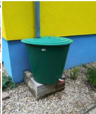
40 pav. Lietaus vandens surinkimas (Kauno Valdorfo darželis „Šaltinėlis“)
