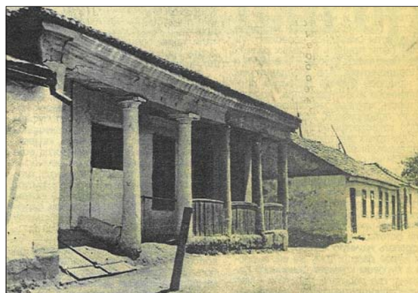
Casă cu galerie, datând din prima treime a secolului al XIX-lea, aflată cândva pe fosta stradă Asiatică, o porțiune dispărută a str. Română. Foto din anii '50 ai secolului al XX-lea
