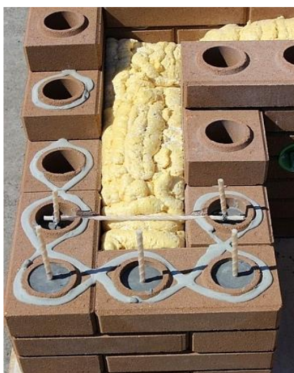
Рисунок 3. Кладка наружной стены
